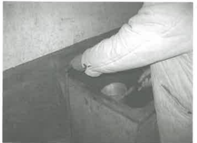
水管直接將水引入屋內
